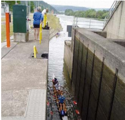
Schleusung am Main
